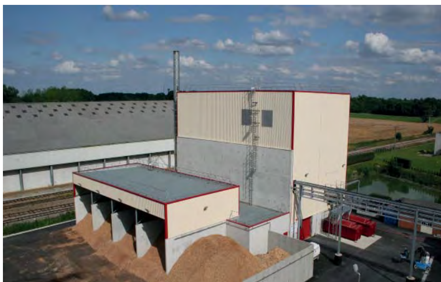
Chaudière à biomasse
