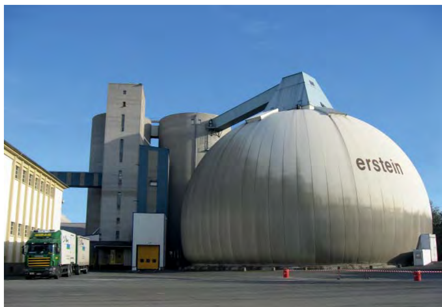
Silo de sucre
