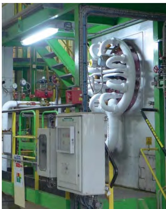
Détail d'une chaudière
