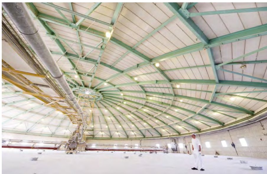
Intérieur d'un silo de sucre
